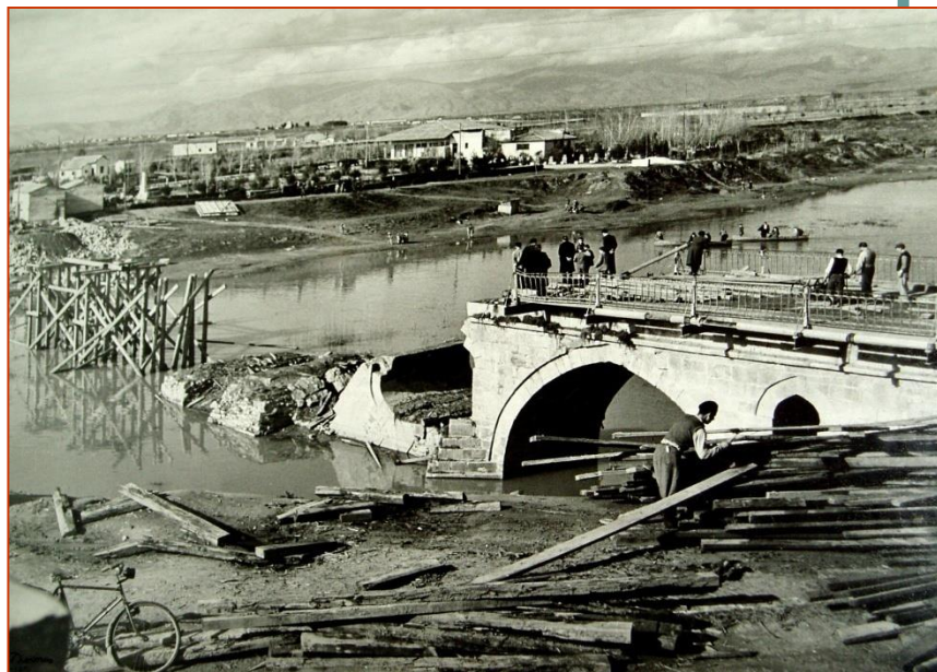
Η κατεστραμμένη γέφυρα από τον πόλεμο 1940-1944
