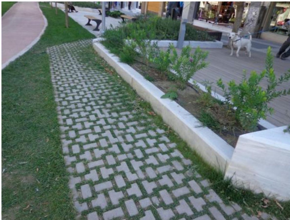
Εικόνα 4.17: Υδροπερατό πεζοδρόμιο στον πρόσφατα διαμορφωμένο πεζόδρομο στο κέντρο της Καλαμαριάς επί της οδού Μεταμορφώσεως.
