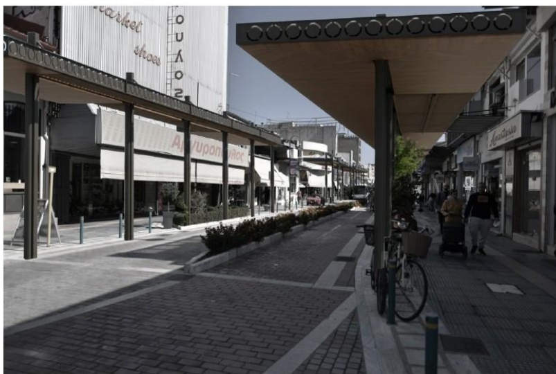
Εικόνα 10: Άποψη Στεγάστρου της Βενιζέλου
