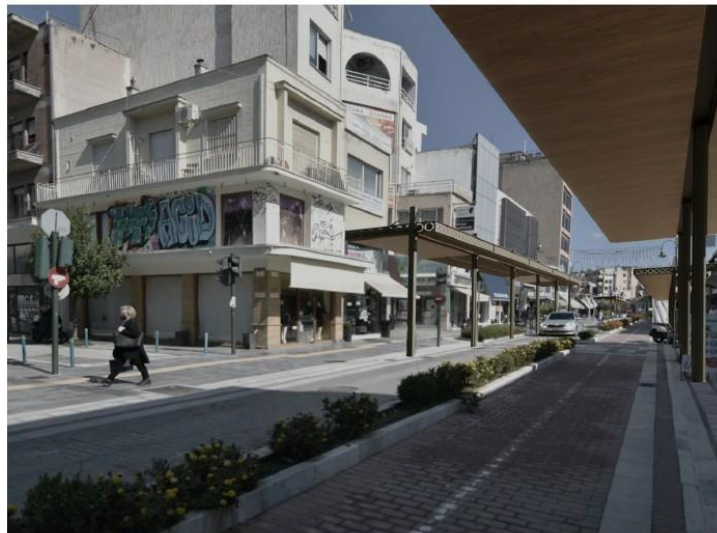
Εικόνα 9: Άποψη Στεγάστρου της Βενιζέλου
