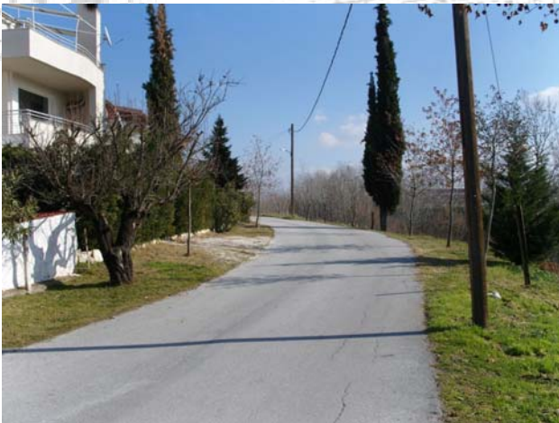
Ασφαλτόστρωση βόρειου αναχώματος
