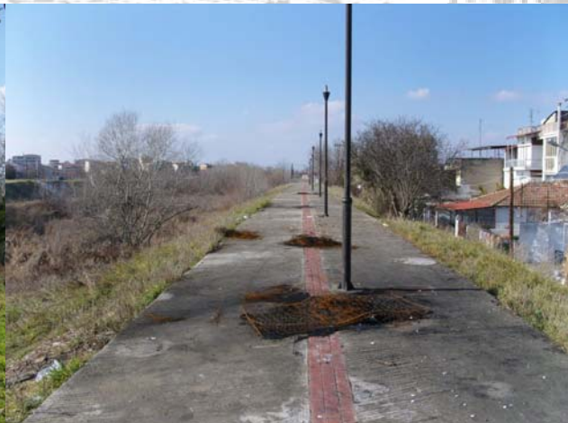
Πεζοδρόμηση βόρειου αναχώματος
